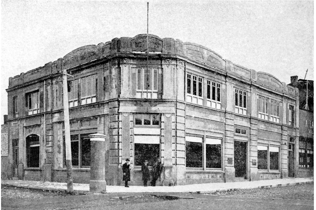
Fig. 1. Edificio de la Administración General de la Sociedad Explotadora de Tierra del Fuego (Fotografía 1920).
