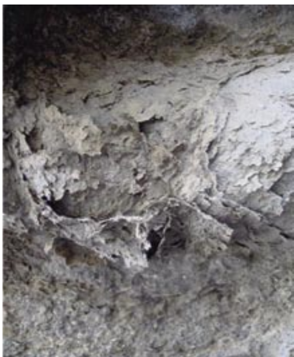
Fig. 3. Exfoliación de la pared arenosa. La alteración de la pared resulta en un sedimento arenoso carbonatado.
